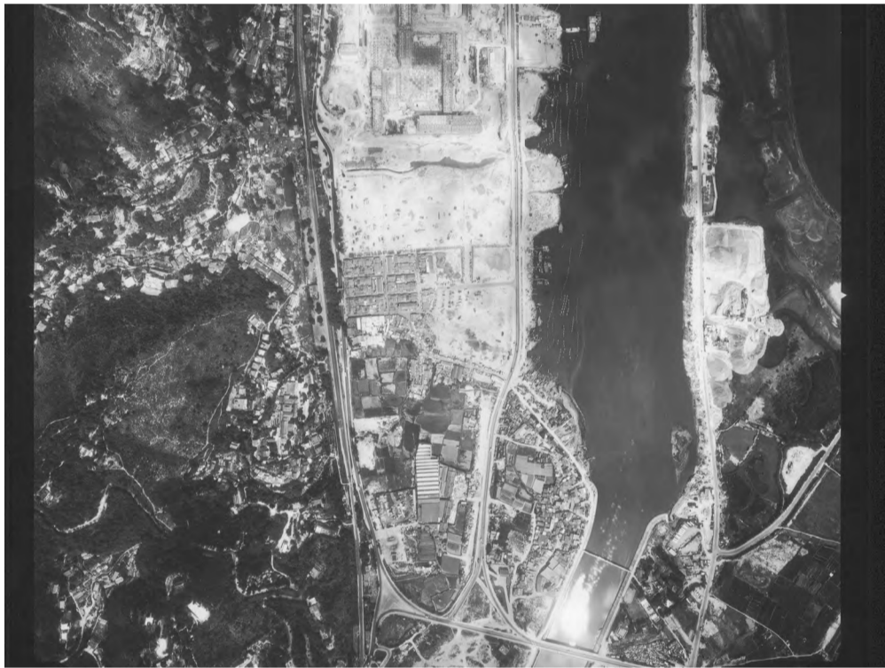
1975年的航空照片顯示建設中的沙田新市鎮 Aerial photo of Sha Tin New Town under construction in 1975. 圖片來源 Picture source: 香港特別行政區政府空間數據共享平台 Common Spatial Data Infrastructure Portal, HKSAR Government
